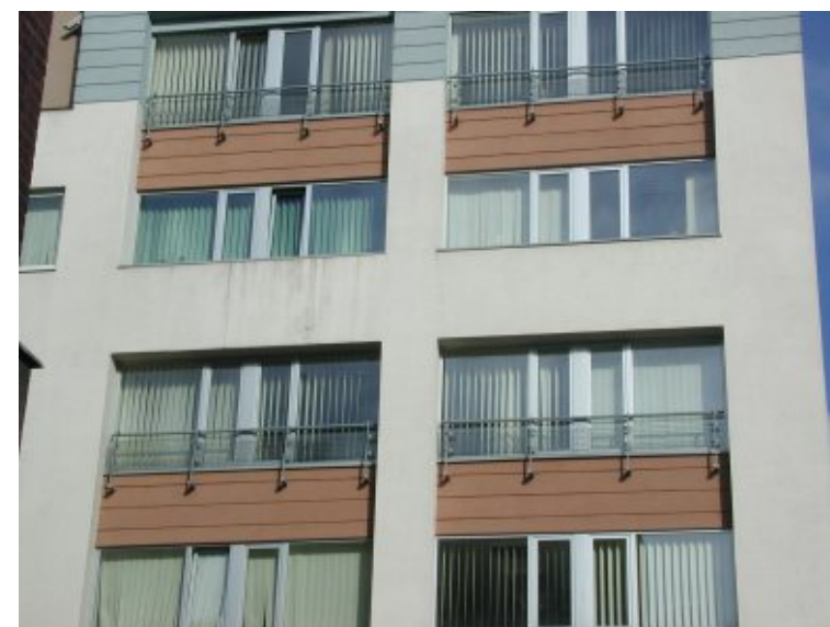
Zdjęcie Nr 1. Przykład źle osadzonej stolarki okiennej. Zbyt małe odsunięcie okapnika (po lewej) od płaszczyzny elewacji powoduje brudny zaciek poniżej usterka taka może być zauważona na elewacji w ciągu kilku tygodni po wykonaniu elewacji i szybko usunięta w ramach rękojmi przez wykonawcę elewacji
